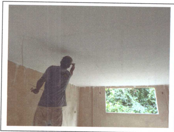
EMASSAMENTO DO TETO
