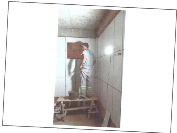
ASSENTAMENTO DE REVESTIMENTO
