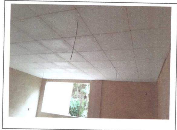
COLOCAÇÃO DE FORRO DE GESSO
