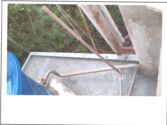
INSTALAÇÃO DA CAIXA DE ÁGUA
