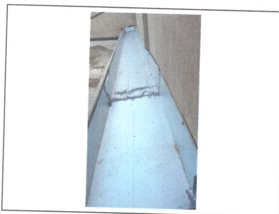
INSTALAÇÃO DA CALHA
