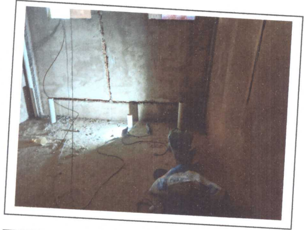
ABERTURA NA ALVENARIA PARA INSTALAÇÃO HIDROSSANITÁRIA
