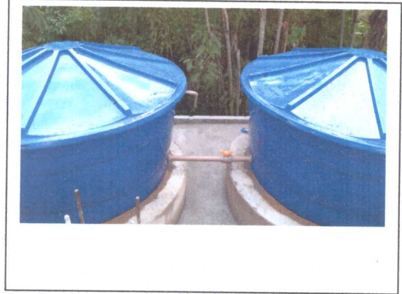
INSTALAÇÃO DA CAIXA DE ÁGUA
