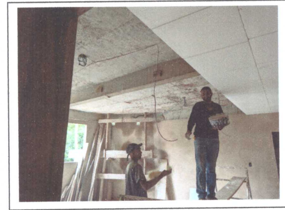
COLOCAÇÃO DE FORRO DE GESSO
