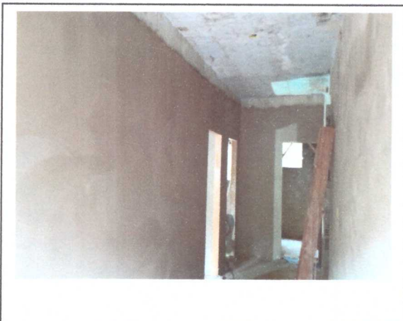
EXECUÇÃO DE REBOCO
