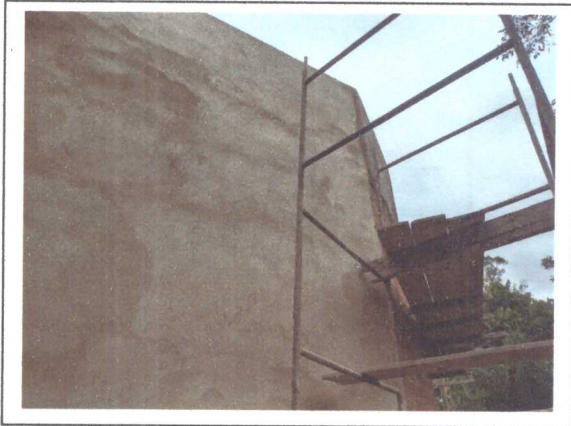
EXECUÇÃO DE EMBOÇO
