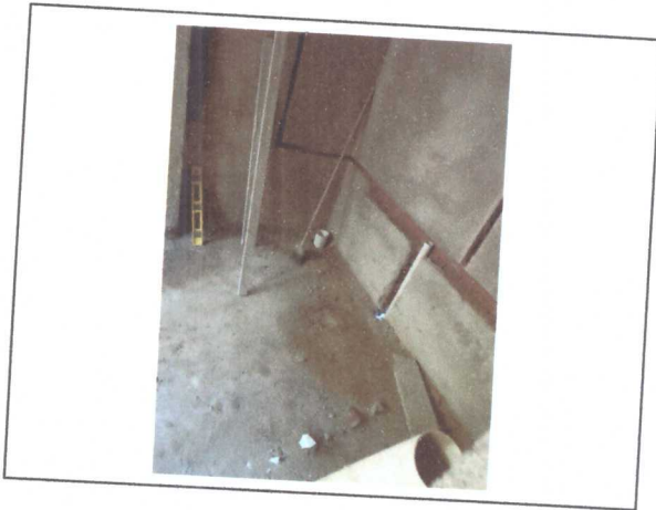
ABERTURA NA ALVENARIA PARA INSTALAÇÃO HIDROSSANITÁRIA
