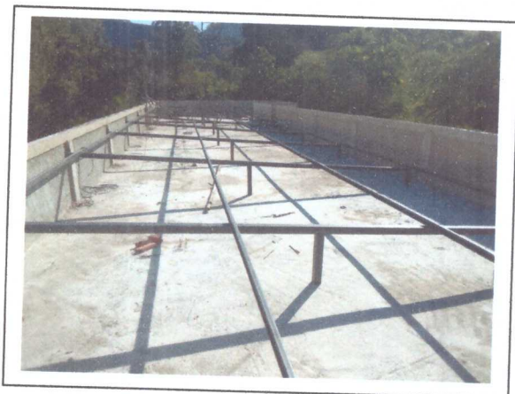
MONTAGEM DA ESTRUTURA DO TELHADO
