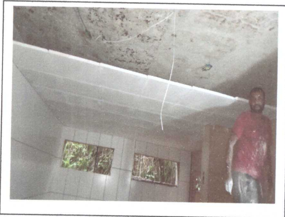
COLOCAÇÃO DE FORRO DE GESSO
