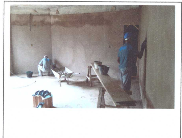
EXECUÇÃO DE REBOCO
