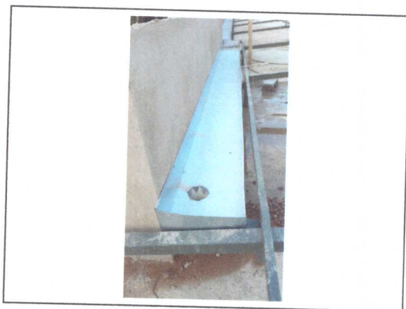
INSTALAÇÃO DA CALHA
