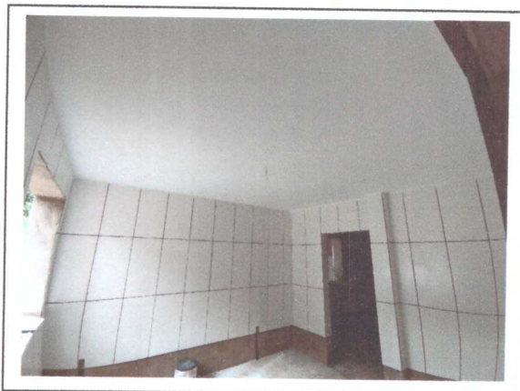
EMASSAMENTO DO TETO
