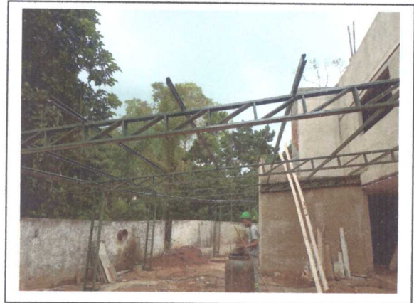
MONTAGEM DA ESTRUTURA DO TELHADO
