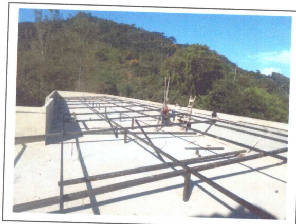
MOTANGEM DA ESTRUTURA DO TELHADO
