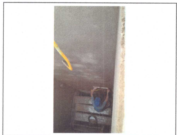
EXECUÇÃO REBOCO (CAIXA DO ELEVADOR)
