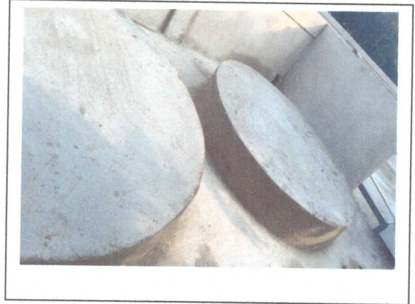
EXECUÇÃO DE BASE PARA CAIXA DE ÁGUA
