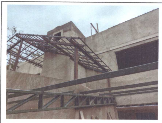
MONTAGEM DA ESTRUTURA DO TELHADO
