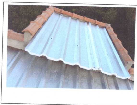
INSTALAÇÃO DAS TELHAS
