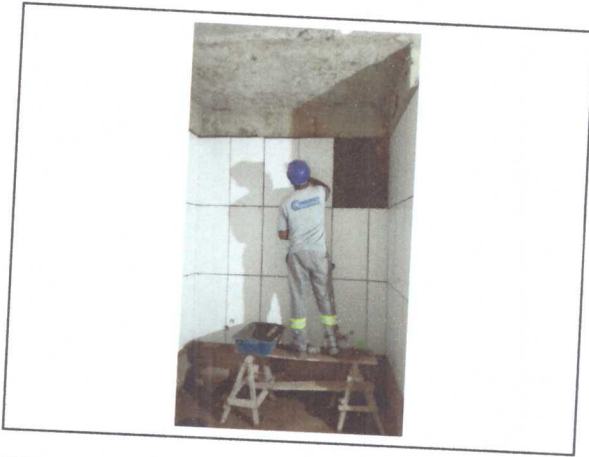
ASSENTAMENTO DE REVESTIMENTO
