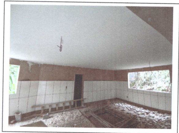
EMASSAMENTO DO TETO
