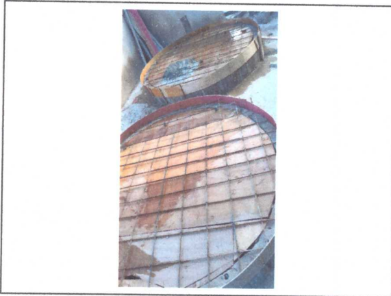
EXECUÇÃO DE BASE PARA CAIXA DE ÁGUA
